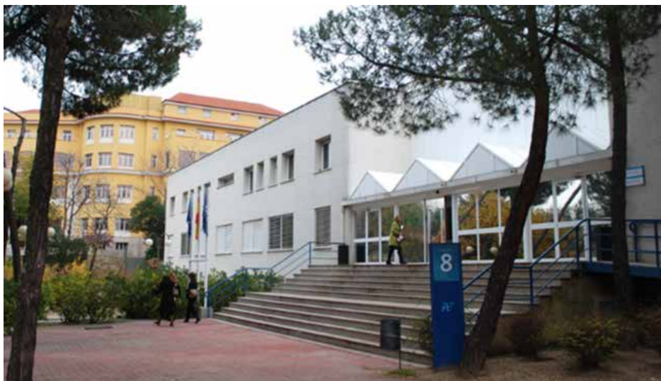
Imagen 91. Vista exterior del edificio de ampliación de la Escuela Nacional de Sanidad.
