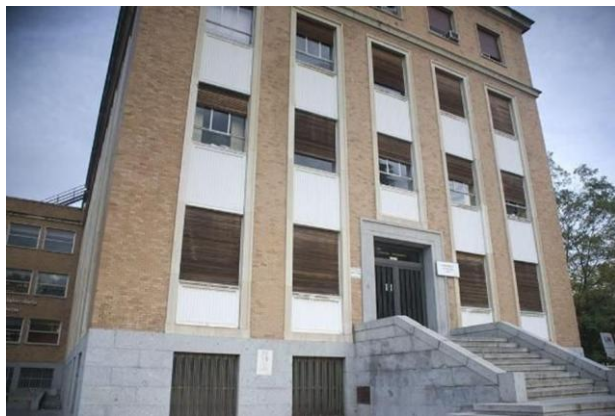
Sede de la Escuela Nacional de Sanidad entre 1947 y 1988. Pabellón 1 de la Facultad de Medicina. Universidad Complutense de Madrid. Fuente: Wikipedia
