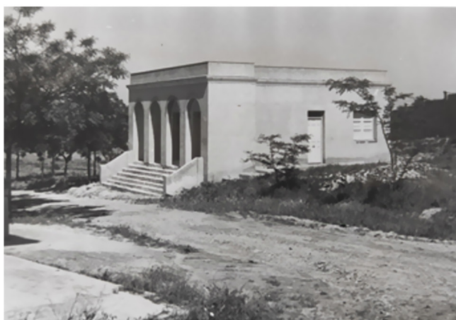
Pabellón de Despiojamiento. Hospital del Rey.
