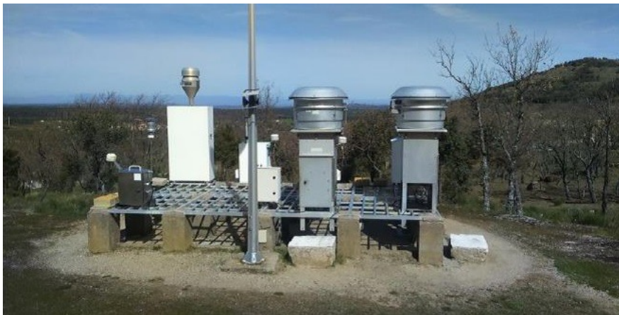
Estación de medición de San Pablo de los Montes, en Toledo.
